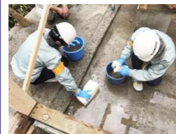
▲雨水の吸取り作業を行いました。
