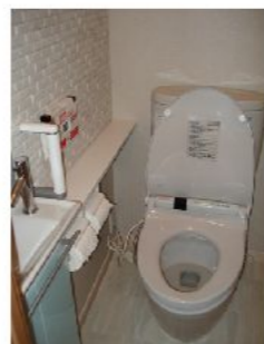
壁面は消臭・調湿効果のある エコカラット貼(タイル)
