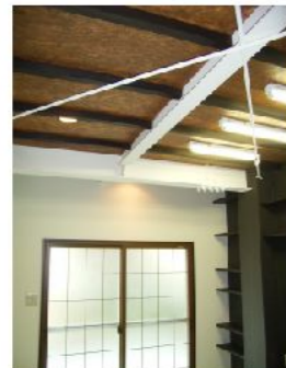
天井は鉄骨を見せてOSBボード貼りに
