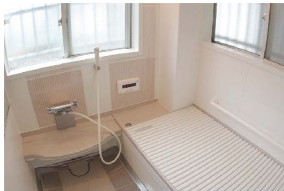
▲鉄骨造の柱型がありました。通常のユニットバスにすると既存より狭くなる為、タカラスタンダードの「ぴったりサイズシステムバス」を採用しました。
