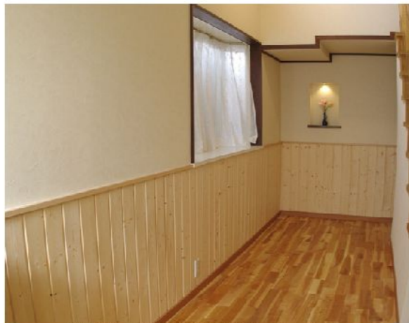
▲腰壁と床に無垢材を使用しました 正面の壁には照明付きのニッチを造作しました
