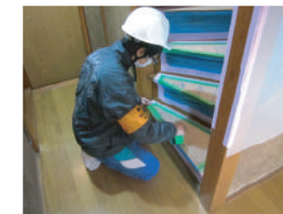
▲ 壁や階段を保護する養生作業を体験中。
