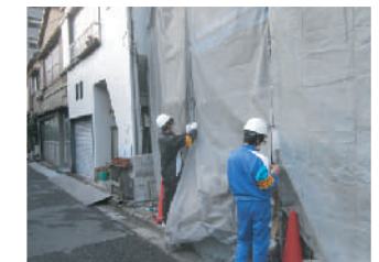
▲ 飛散防止シート設置作業を体験中。
