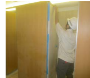
▲養生の撤去作業を体験中。
