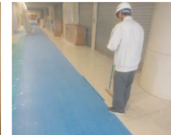
▲現場の片付け・清掃作業を体験中。
