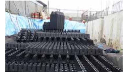
▲駐車場の地下に貯留材を埋設する様子
